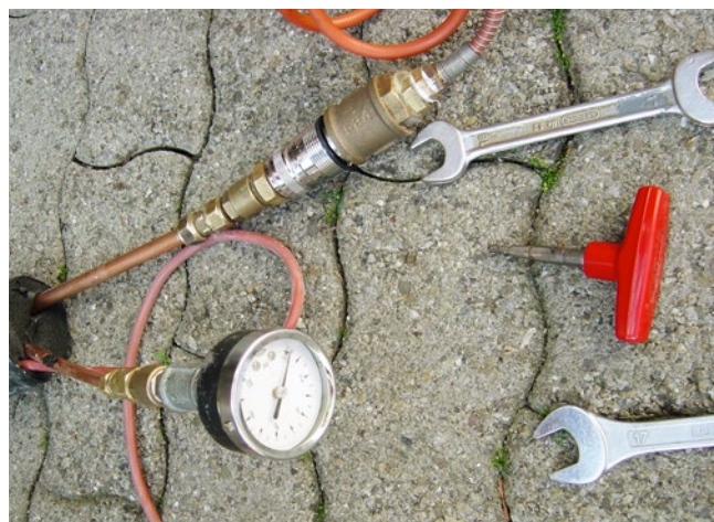
[FIG. 1] Essai d'étanchéité.
